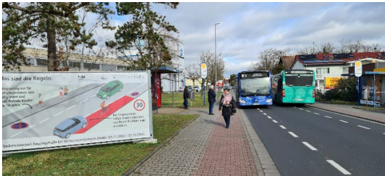
Abbildung 4: Industriestraße mit beidseitigen Schutzstreifen und einstreifiger Kernfahrbahn im Bereich der Bushaltestelle
