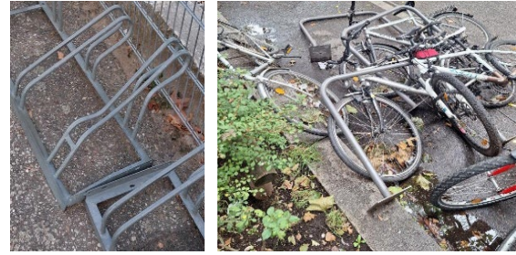
Abbildung 12 (links): Verbogener Vorderradhalter Abbildung 13 (rechts): Kaputte, aufgedübelte Anlehnbügel
