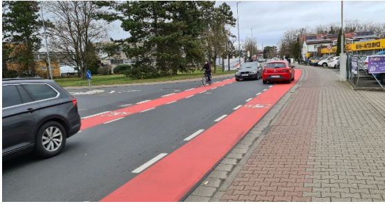
Abbildung 3: Industriestraße mit beidseitigen Schutzstreifen und einstreifiger Kernfahrbahn sowie Rotmarkierung an Knotenpunkten
