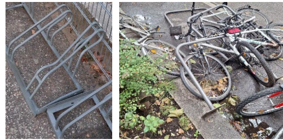
Abbildung 12 (links): Verbogener Vorderradhalter Abbildung 13 (rechts): Kaputte, aufgedübelte Anlehnbügel (Eigene Bilder)
